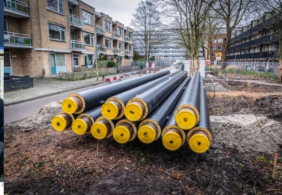
▲ De aanleg van een warmtenet. © Nico Schouten
