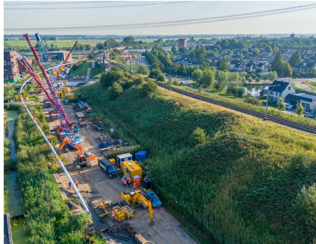
Aanleg van warmteleidingen onder rivier de Merwede (foto HVC).
