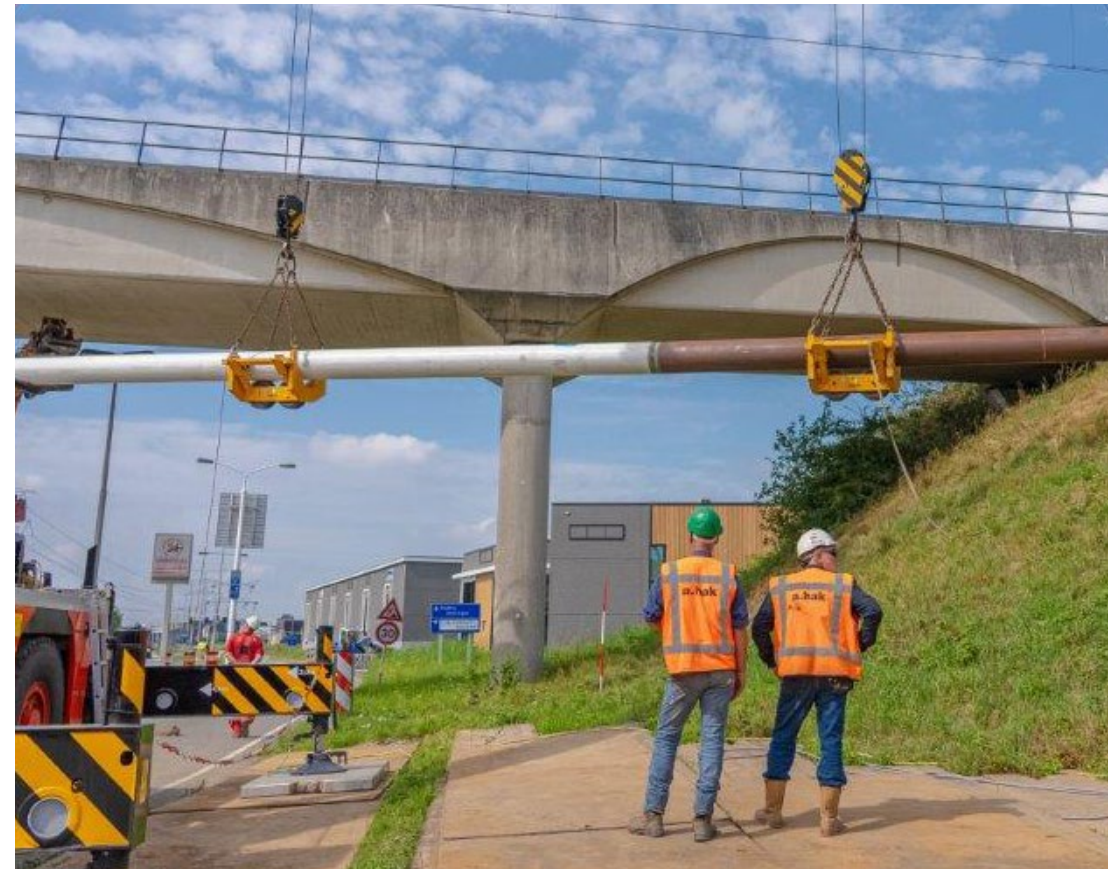
Aanleg van leidingen voor het transport van duurzame warmte, gewonnen uit afvalwater, tussen Slidrecht en de HVC Slibverwerkingsinstallatie in Dordrecht.
