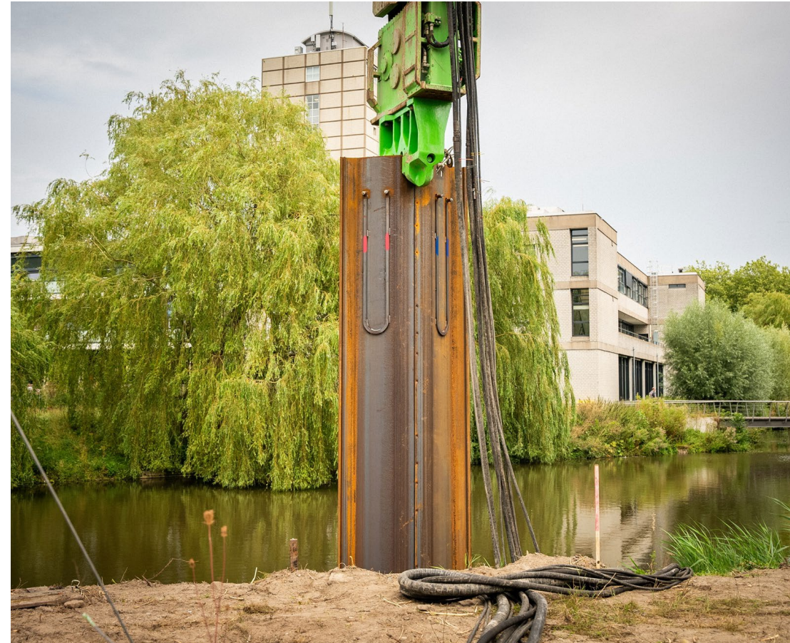
Een energiedamwand is een damwand die ook werkt als een duurzame warmtewisselaar (foto Energiedamwand Nederland).
