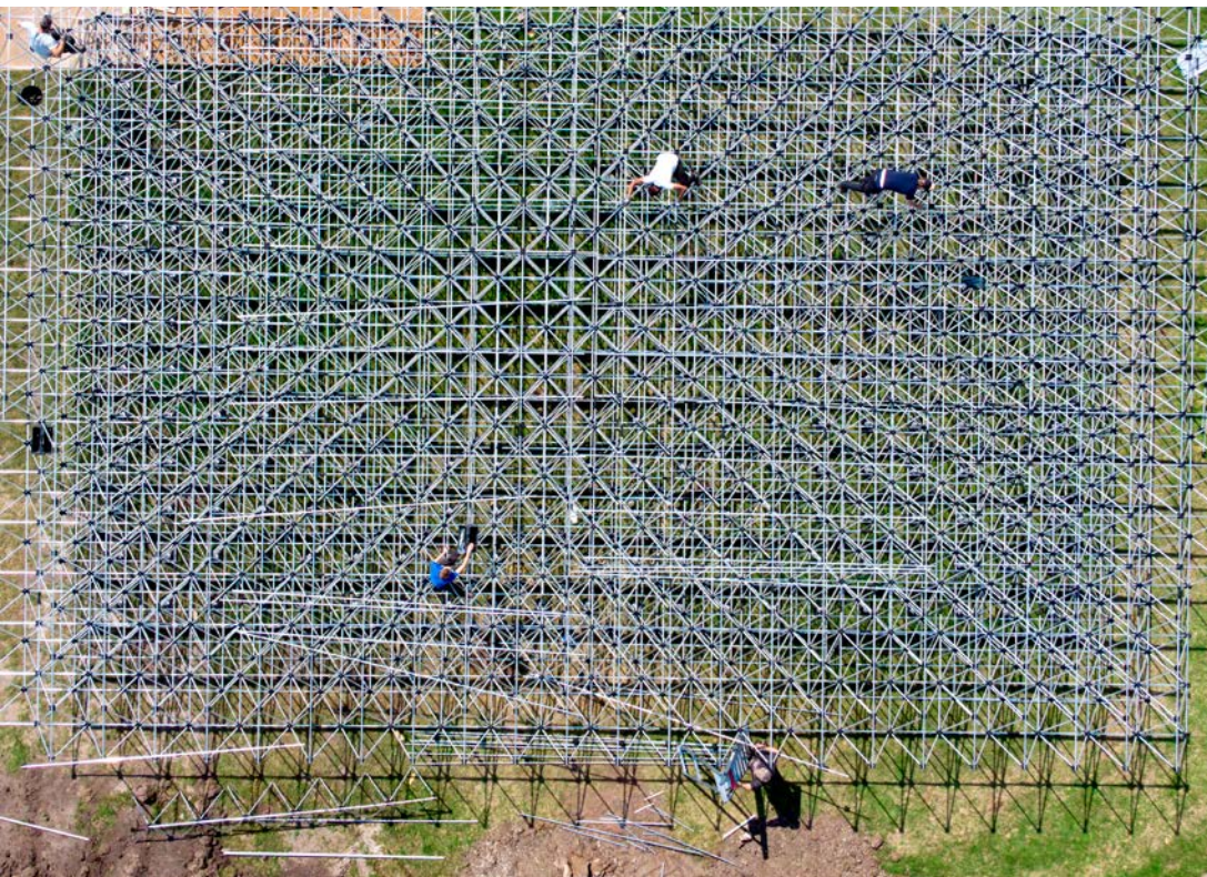
Aanleg van warmteopslag
