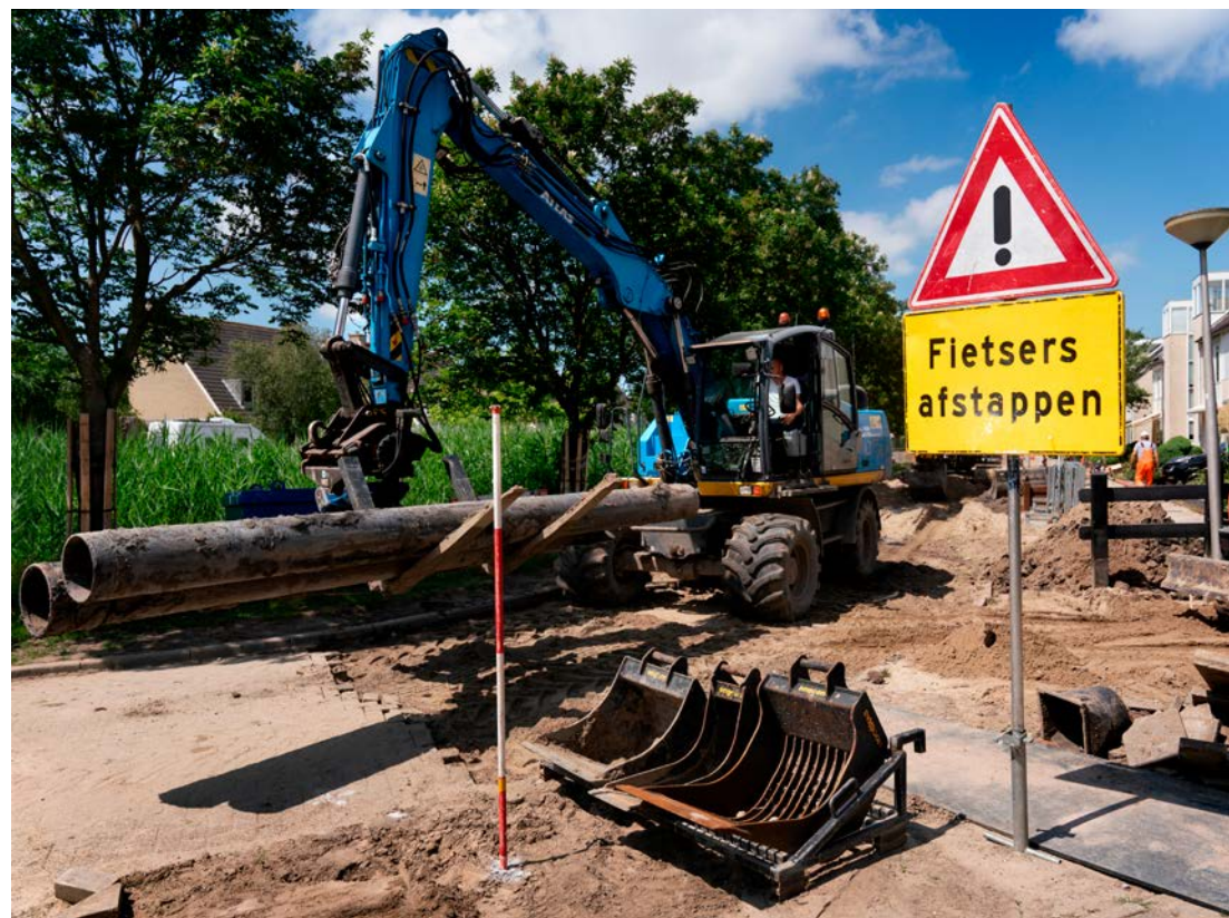
In Pijnacker-Nootdorp wordt gewerkt aan een MT-warmtenet met geothermie als bron.
